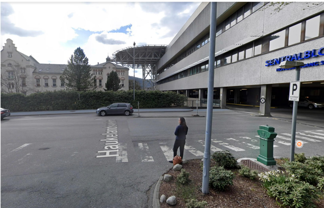
Figur 2: Landingsplass på HUS. Sett not vest, på sørsiden av sentralblokken. (Foto: Google maps).
