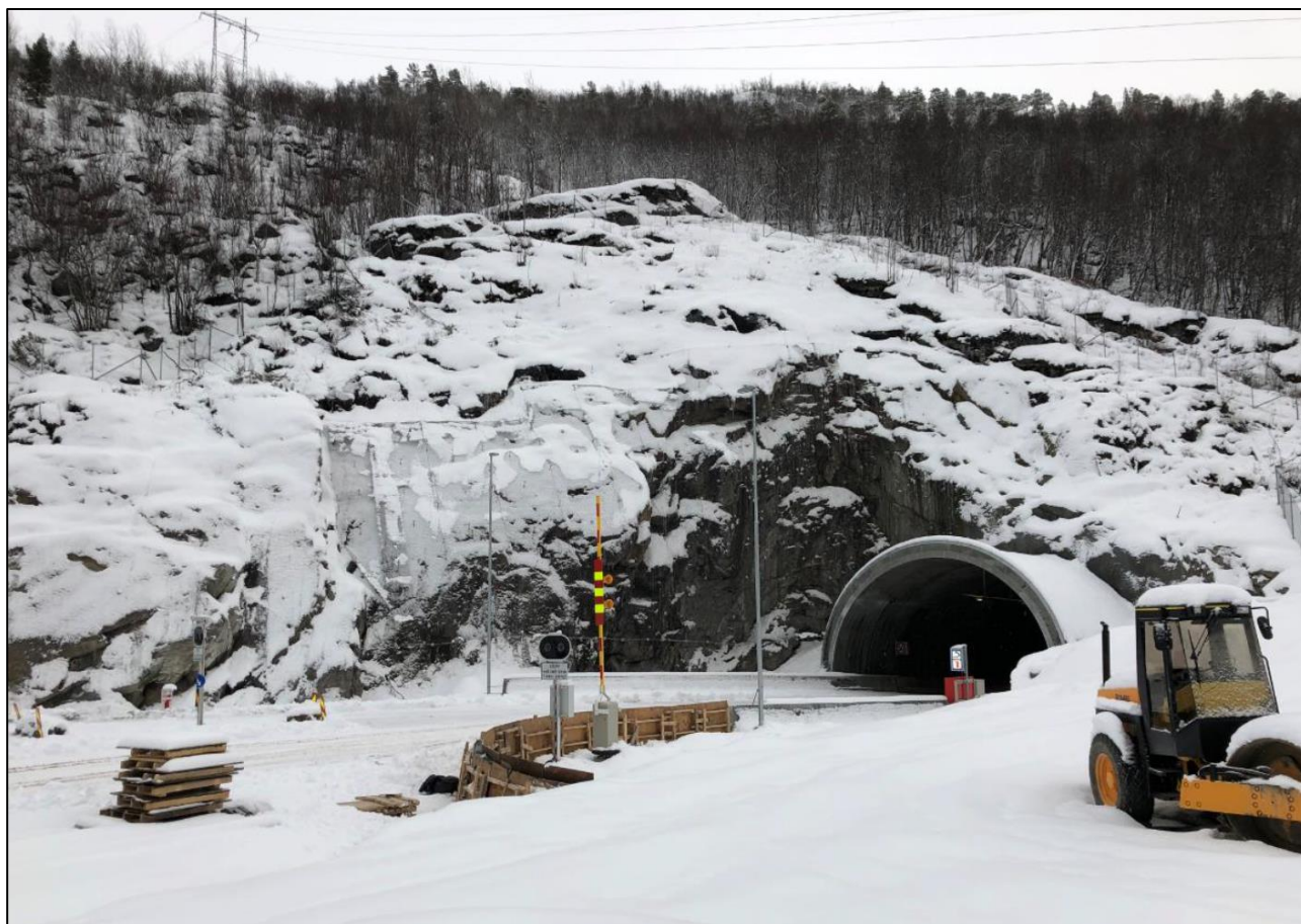
Figur 5-10: Tunnelpåhugg øst. Bilde fra befaring 5. november 2019.
